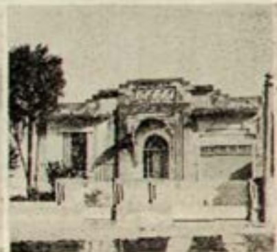
Propiedad ubicada en la calle Anzani N° 2015; de Montevideo.
