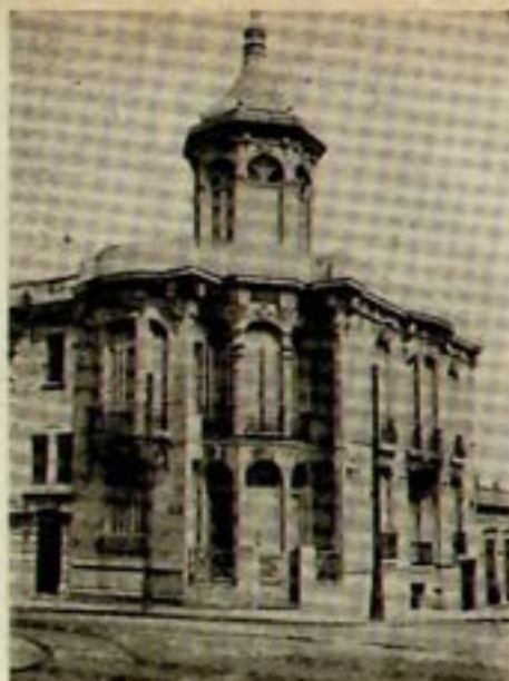
Propiedad ubicada en la calle Juan M. Blanes N° 900; de Montevideo.
