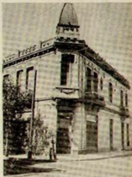
Propiedad ubicada en la calle Constituyente N° 1802-08; de Montevideo.
