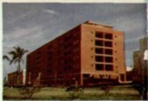
Edificio de renta ubicado en la Ram- bla Sur y Pérez Castellano.
