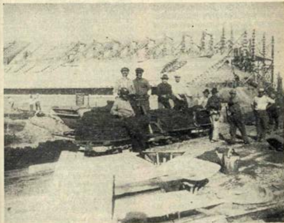
Iniciación de los trabajos de engramillado, pudiendo observarse paralelamente las obras de hormigón de la Tribuna América.
