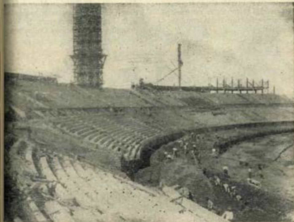
Un aspecto de la construcción de la Tribuna Olímpica, advirtiéndose el encofrado que rodea a la Torre de los Homenajes.
