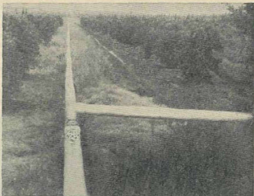
Cañerías de Riego
