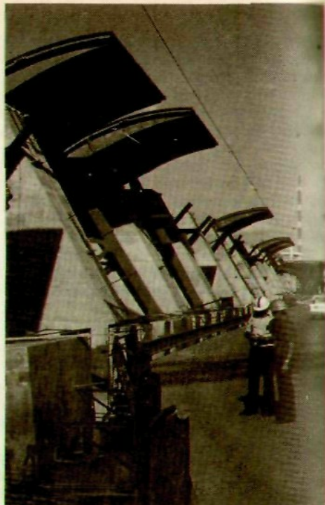
Fig. 1. SALTO GRANDE. Compuertas radiales y hombres de seguridad.
