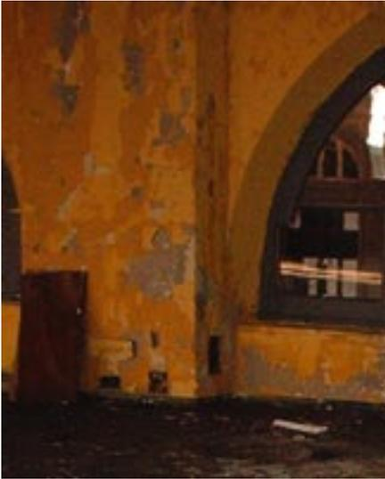
Desborde de canalón de aguas pluviales provocado por obstrucción de uno de los caños de bajada. El ejemplo corresponde a la Estación Central de AFE.
