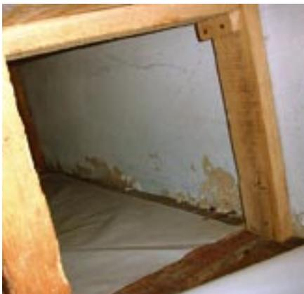
Humedad de cimiento que asciende por capilaridad del muro al fallar la barrera horizontal impermeable.
